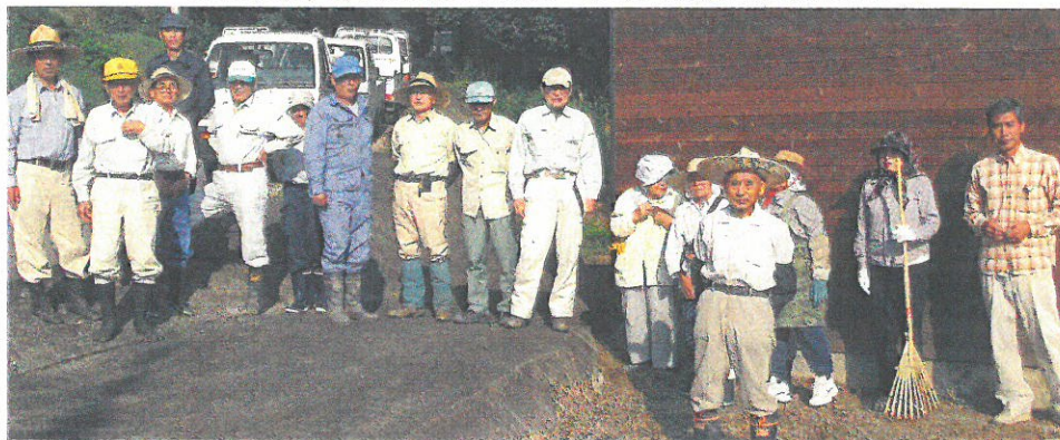
Ⓔ会員の皆さん Ⓕ自主施工による農道舗装作業
